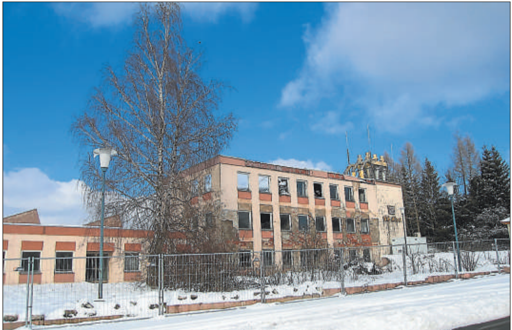
Die Lenkungsgruppe diskutierte die Zukunft der ehemaligen Möbelfabrik WM in Hollfeld. Geplant ist zunächst, die Gebäude abzureißen und das Gelände auf Altlasten zu untersuchen. Foto: Leikam
