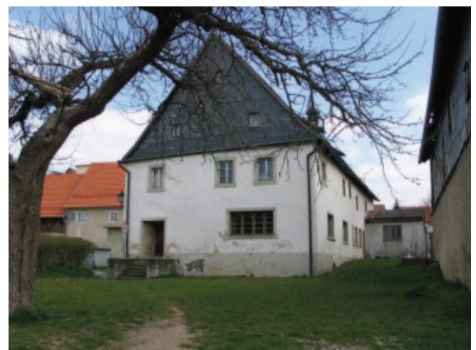
Bildmontage (oben) & heutiger Zustand (unten): Der rückwärtige Bereich des Spitals könnte zu einem kleinen Bürgergarten mit Ruhezonen und Kräutergarten umgestaltet werden. Derzeit bietet die Fläche keine Qualitäten.
