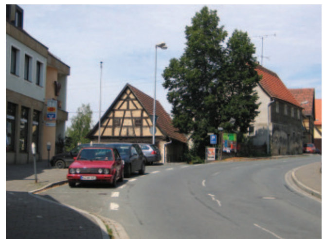
Heutiger Zustand: Der Bauzustand der Bestandsgebäude an der stark befahrenen Bamberger Straße ist sehr schlecht.
