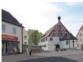
Das Spitalgebäude sollte saniert und einer neuen Nutzung zugeführt werden.
