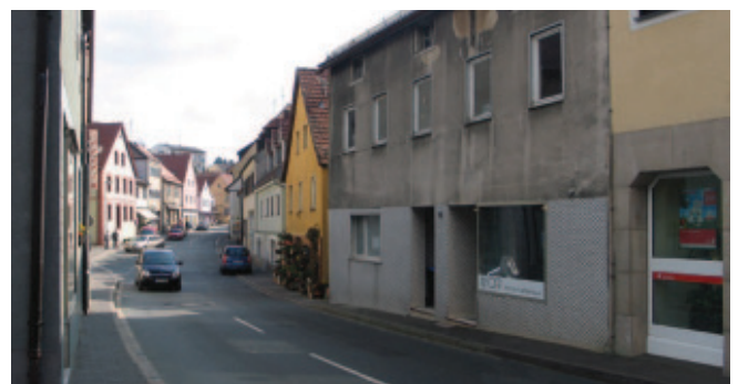
Heutiger Zustand: Aufgrund des vorgegebenen Straßenquerschnitts durch die Bestandsgebäude und die Anforderungen an eine Bundesstraße lassen sich die Gehsteige derzeit nicht verbreitern.
