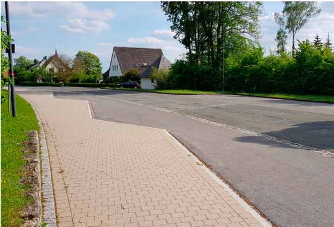
47 vorher: Bestehende Situation an der Bushaltestelle Gesamtschule
